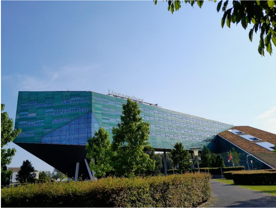
Abbildung 1 Biologie Gebäude an der Rijksuniversiteit Groningen
