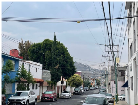
Toluca. Die Stromleitungen dürfen natürlich nicht fehlen.
