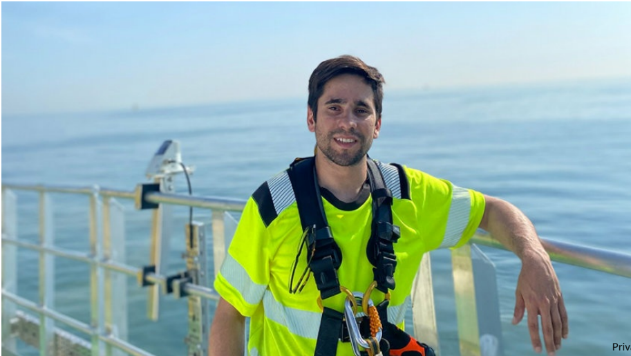
DAAD-Alumnus Mario Cornaló bei seiner Arbeit auf einer Offshore-Baustelle.
